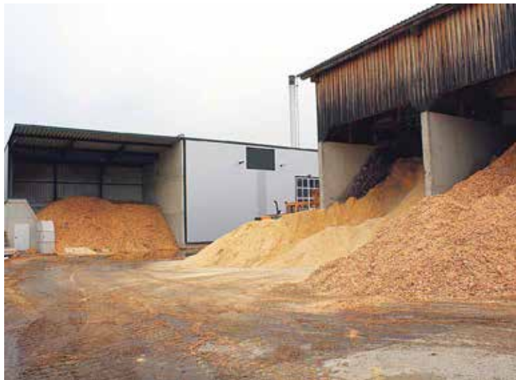
Die Sägespäne sind die Grundlage für das dahinter liegende Heizwerk.
